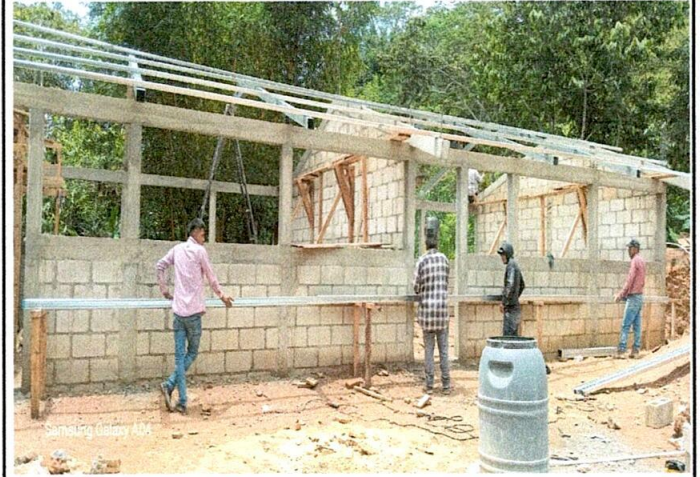
Foto 2: Colocación de techo.
